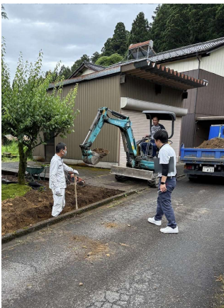
外構工事の現場。 指示を出し確認する、水野。
