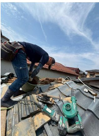
屋根瓦の修繕。 隅棟を積み直しています。
