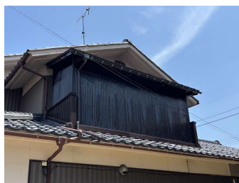
■ベランダの改修。波板張替え、塗装等を行いました。
