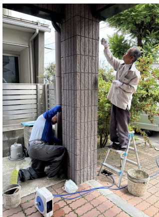
外壁タイルの修繕。 左官屋さんが作業しています。
