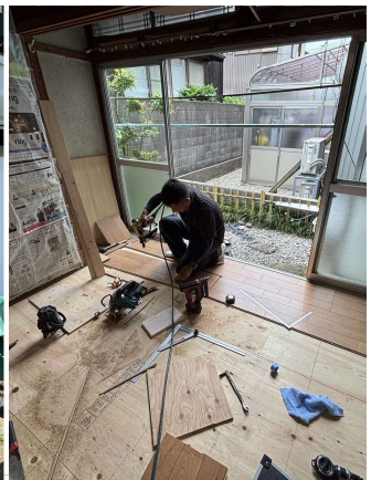
スタッフ寺嶋。 フローリングを張っています。
