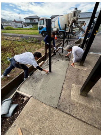
フェンス設置の現場。 コンクリートを均す、水野。
