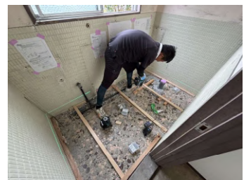
■トイレ改装工事の現場。大工さんと現場監督の二刀流。
