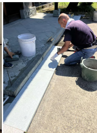
玄関先の石張り修繕。 笏谷石を張っています。
