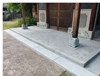
■玄関先の土間の笏谷石が割 れたので修繕しました。
