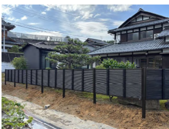
■竹垣フェンスの設置工事を させていただきました。
