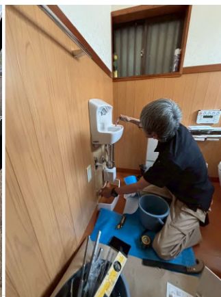
トイレ手洗い器交換。 水道屋さんが交換作業中。
