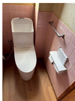
■トイレ床から下地して嵩上げし、フロアタイルを張り直しました。洋便器も入替えました。
