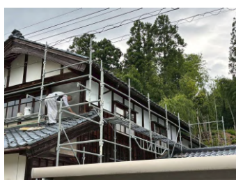
■蔵の白壁と掛け屋根の修繕、さらに雨樋も入替えました。
