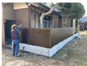
■ブロック塀を壊し、新しくアルミフェンスにしました。
