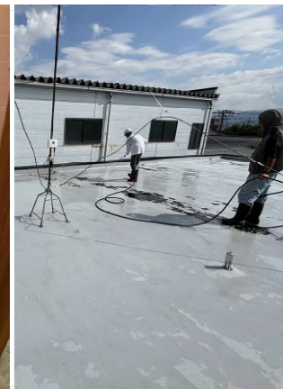
屋上防水工事中の現場。 高圧洗浄をしています。
