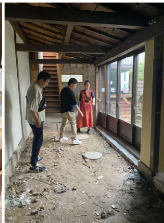
金沢へ研修に。 町家改修の現場を見学。
