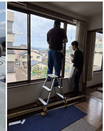
断熱効果を高めるため 内窓取付け工事をしています。
