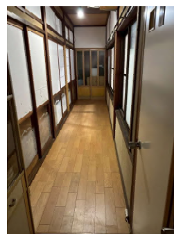
■廊下床の修繕工事。床を解体し、床下地から直しました。
