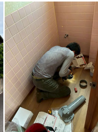
トイレ改修工事の現場。 排水管を調整中。
