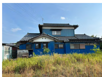
■壁の張替えと塗替えをしました。雨樋も修繕しました。
