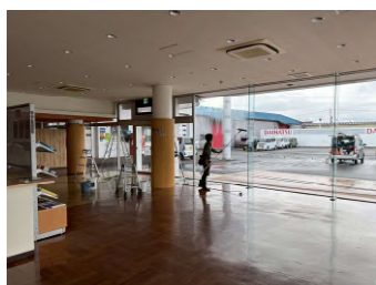
■店舗のクリーニング工事をさせていただきました。
