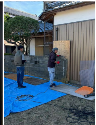
ブロック塀を解体し、 アルミフェンスにします。
