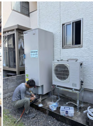
エコキュート入替え現場。 水道屋さんが交換作業中。
