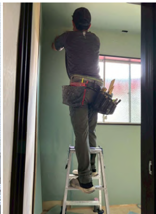
トイレ改装工事の現場。 クロスを張っています。
