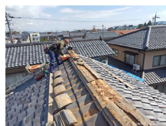
■屋根瓦の修繕工事をさせていただきました。
